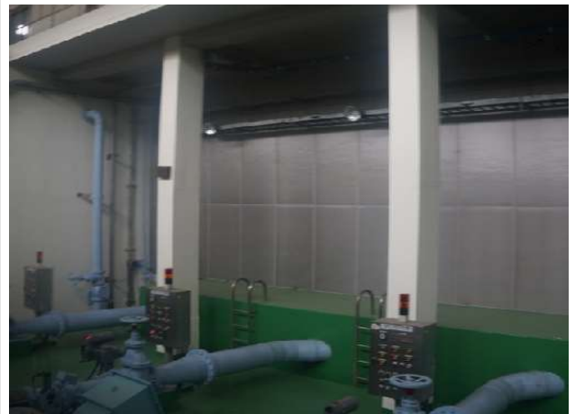
펌프실 지하1층 기둥 상태양호
