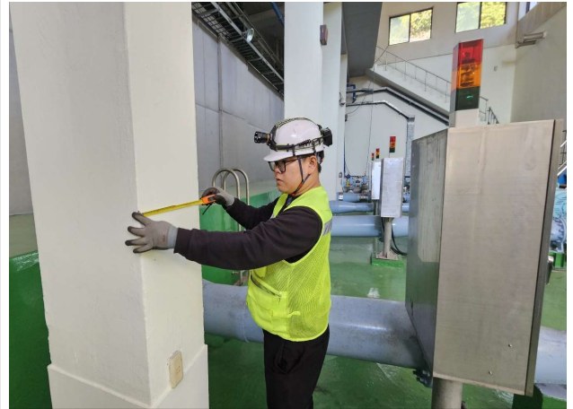
외관조사 시 전경
