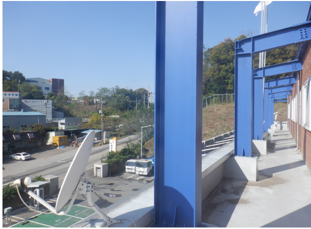
옥탑층 외부 철골부재 상태양호
