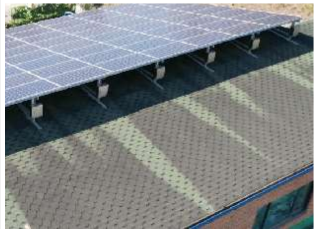
건축물 옥탑층 외부 지붕층 상태양호
