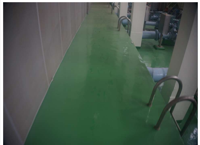
펌프실 지하1층 바닥슬래브 보수상태 양호
