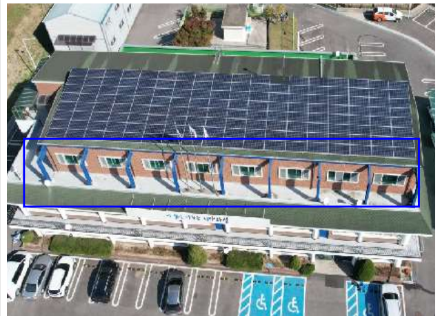
옥탑층 외부 철골부재 상태양호
