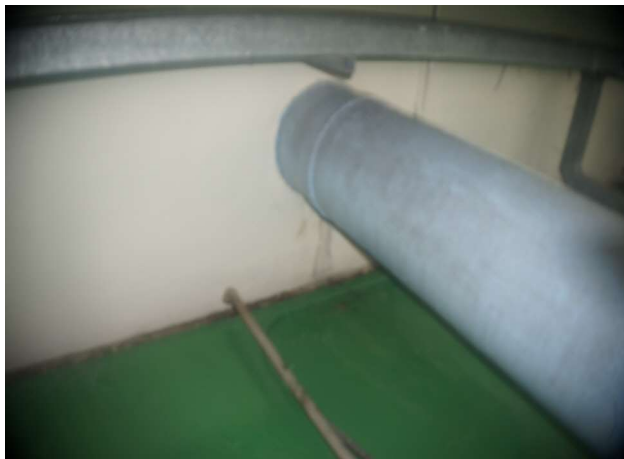
펌프실 지하1층 바닥슬래브 보수상태 양호
