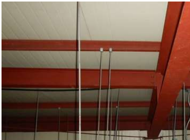
옥탑층 상부 지붕층 하부 철골부재 상태양호
