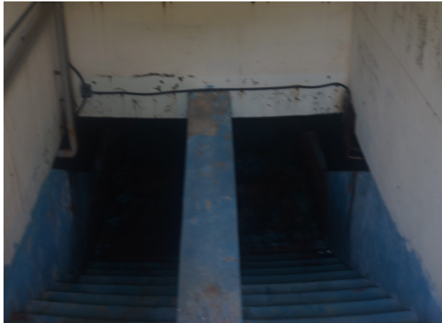
1~2호지 안전난간 상태양호
