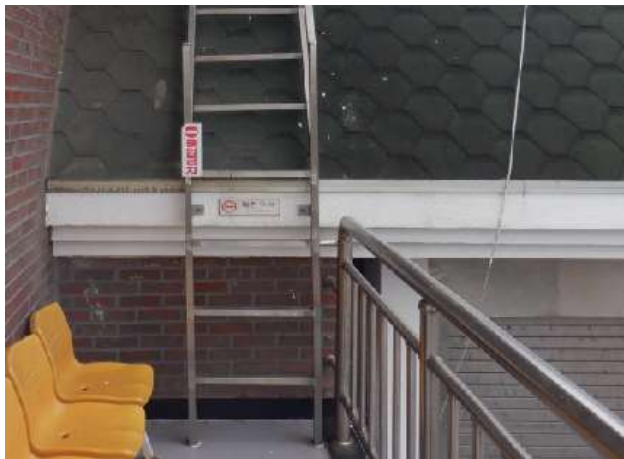
지상1층 펌프실 외부 파라펫 보수 현황
