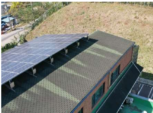
건축물 옥탑층 외부 지붕층 상태양호
