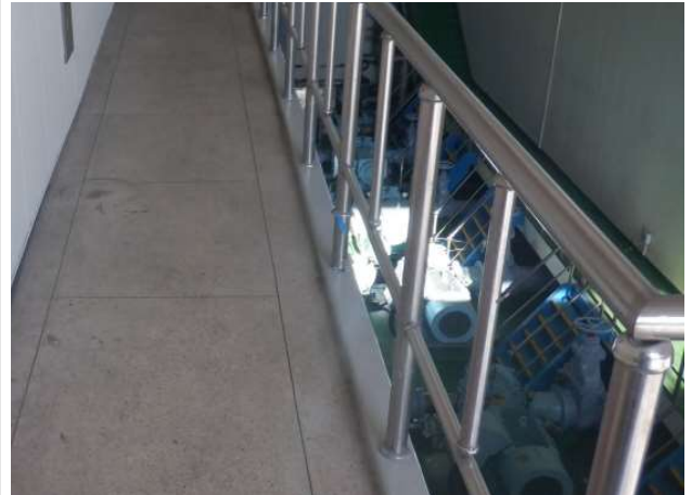
펌프실 안전난간 상태양호
